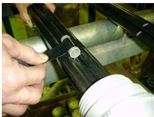
図 5.6.4 円形注入スペーサーの取付状況
