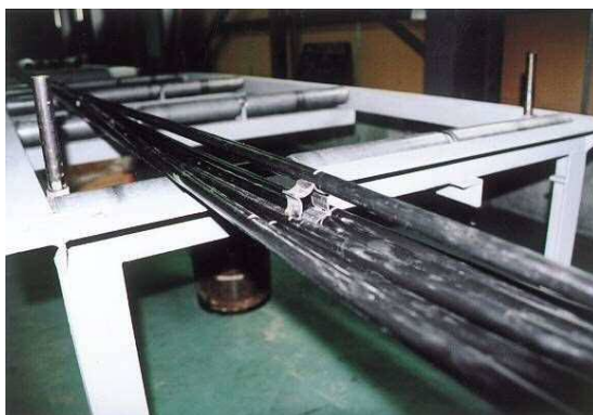
図 5.6.6 星型注入スペーサーの取付
