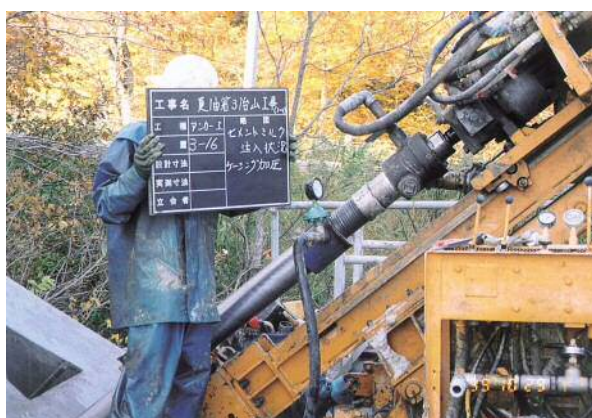
図 5.9.4 加圧ヘッドによるケーシング加圧注入
