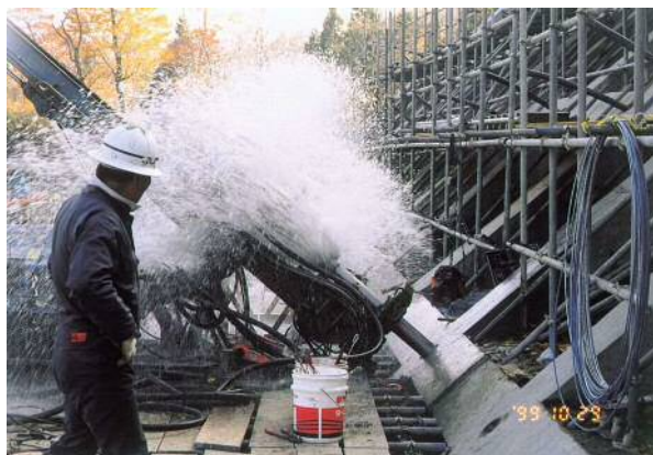
図 5.5.3 孔内洗浄の状況
