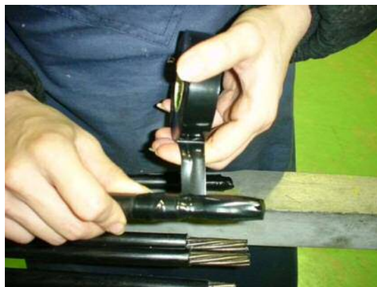
図 5.6.3 アンボンド PC 鋼より線の端部処理 (緊張端側)
