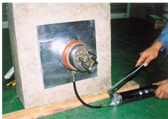
図 5.13.1 ヘッドアダプター内部への防錆材の充填
