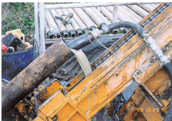
図 5.9.3 置換注入時のグラウトのリターン
