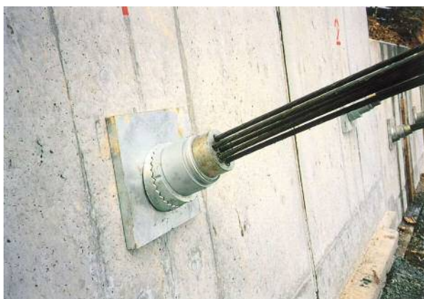
図 4.5.1 角度補正例（アジャストプレート）
