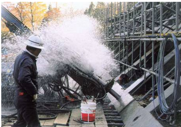
図 5.5.2 孔内洗浄の状況
