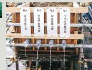
排水状況写真
