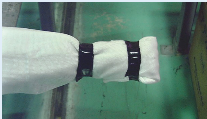
4 パッカー設置後 仮止め (先端部)
