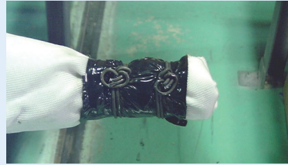
6 番線により固定 (先端部)
